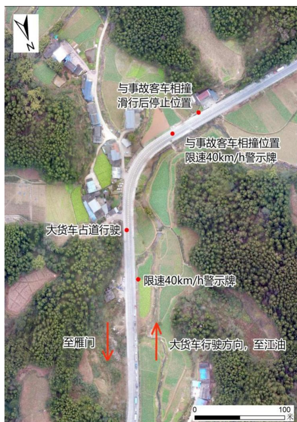
图 4 现场道路情况俯视图
